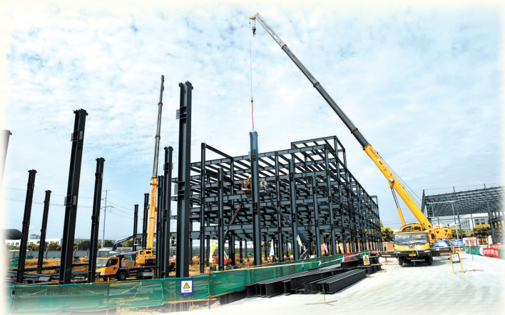
河南元寰科技有限公司项目正紧张施工。
