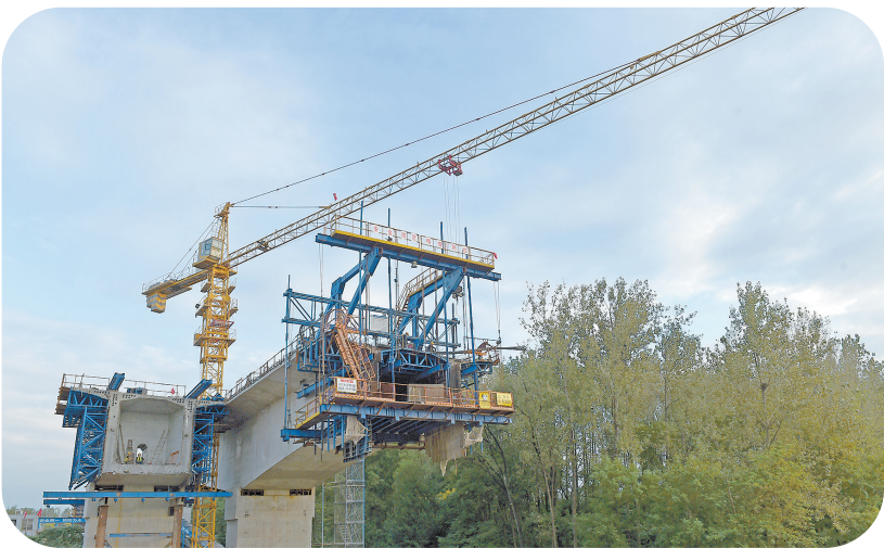
主桥悬臂浇筑施工有序推进。⑥2
