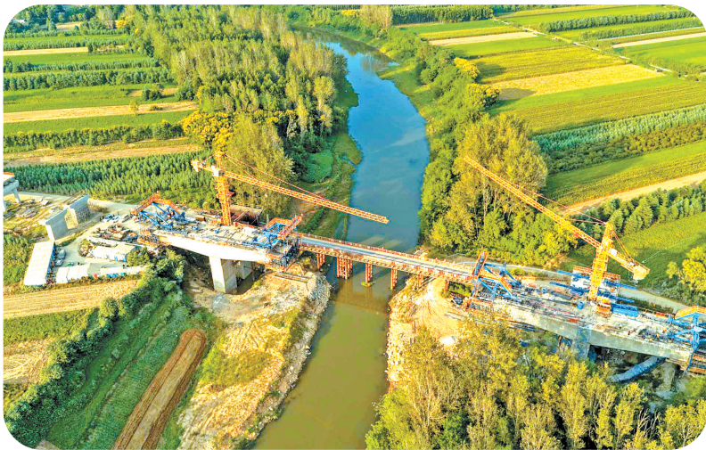
航拍下的漆头河大桥建设现场。⑥2
