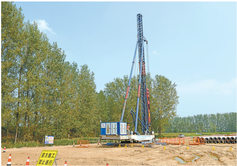
练江河大桥桩基施工。⑥2
