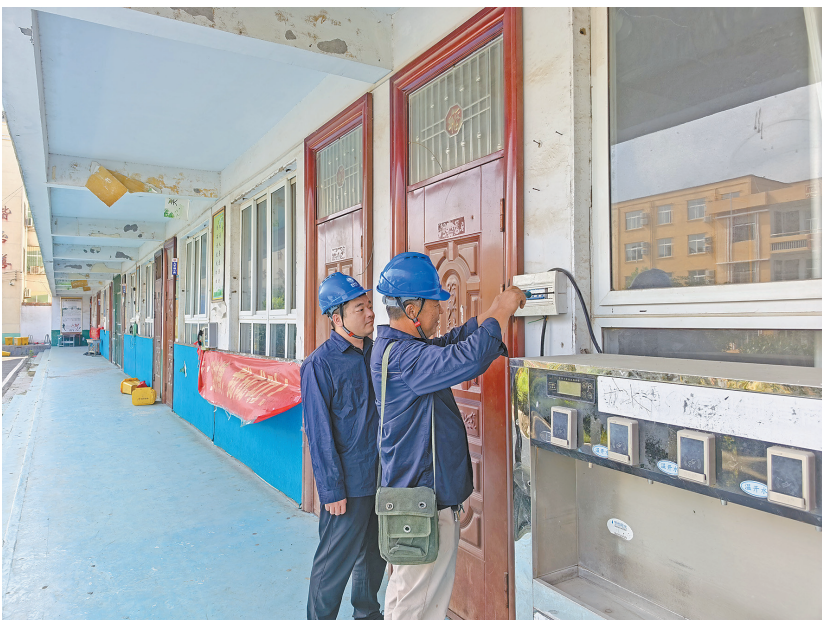
排查校园电力设施。⑥2
