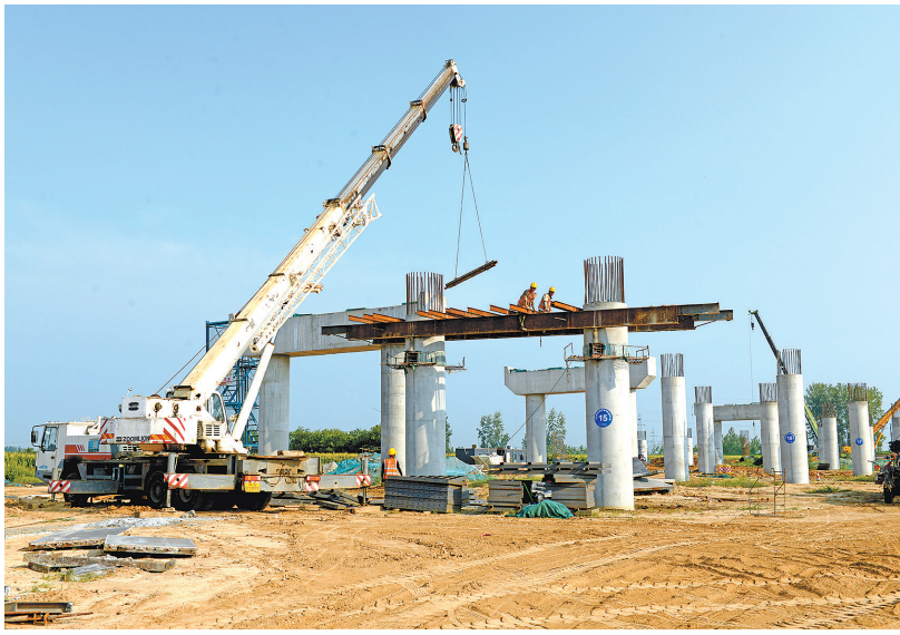
跨G345互通立交桥盖梁施工。⑥2
