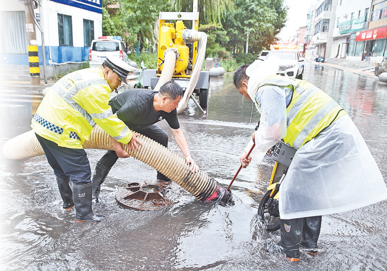
8月11日,河南省开封市尉氏县相关部门工作人员在积水路段进行路面排涝作业。
