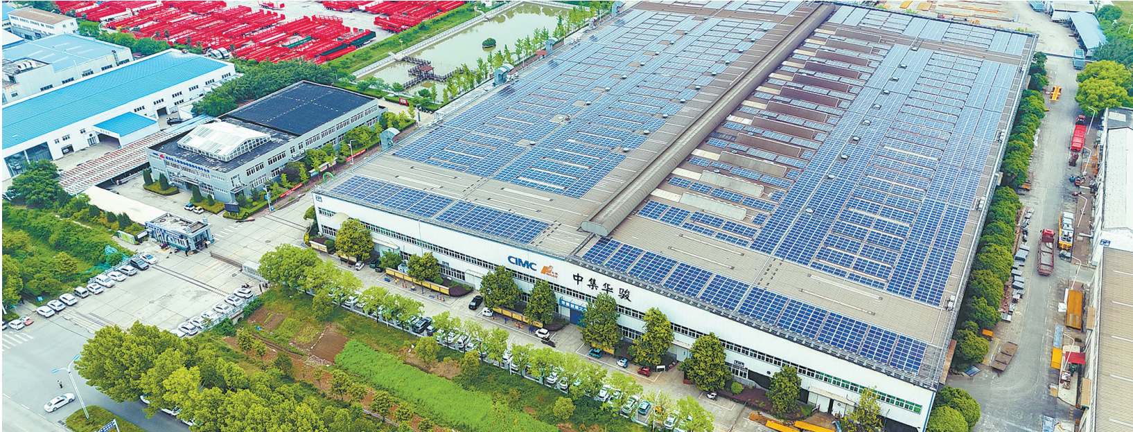
厂区屋顶全部覆盖光伏发电设备。⑥3
