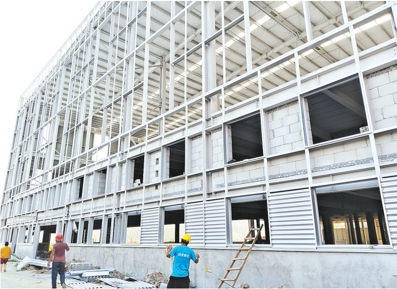
近日，确山县在建项目河南泰源新材料科技有限公司厂房主体框架已经建成，工人正在安装外墙墙体。据了解，该项目主要生产可降解珍珠棉，市场前景广阔。⑥5
