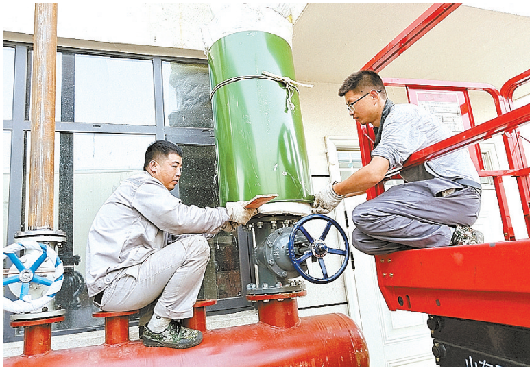
7月22日，在确山县农特农产品产业园项目施工现场，工人抢抓施工节点、争分夺秒推进工程建设。项目建成投产后，由河南小趣领航食品有限公司运营管理，规划3条全自动灌装生产线，开展小趣苏打水自有品牌生产与外来品牌代工业务，项目落地后可带动200人就近务工，持续拓宽群众就业渠道。⑥3
