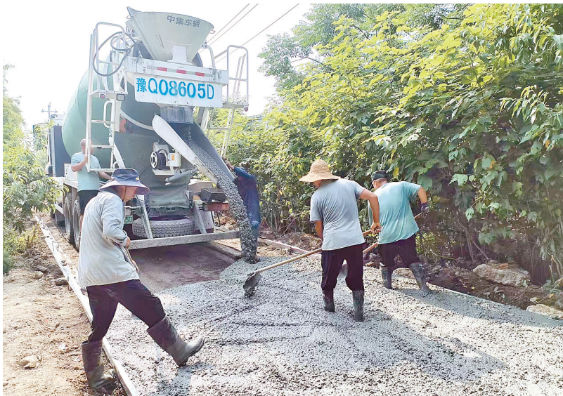
图为工人正在加紧浇筑水泥,修整路面保畅通。⑥3
