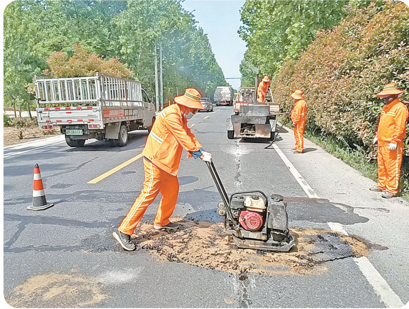
路面坑槽挖补作业。⑥2
