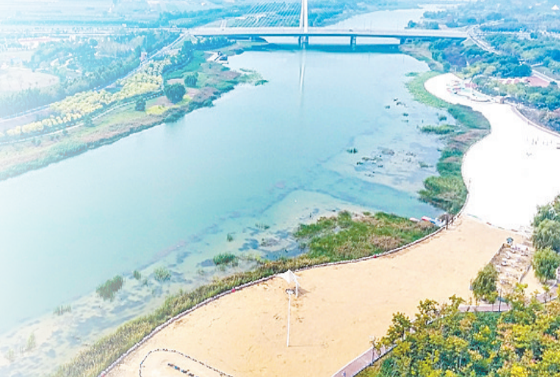
2026年3月24日拍摄的河南省焦作市大沙河生态公园(无人机照片)。
