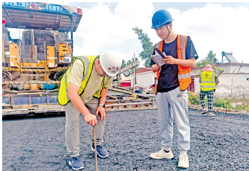
水稳碎石施工过程中厚度检测。⑥2
