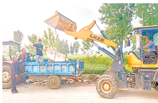
大型机械进行路面平整和废料清运。②3
