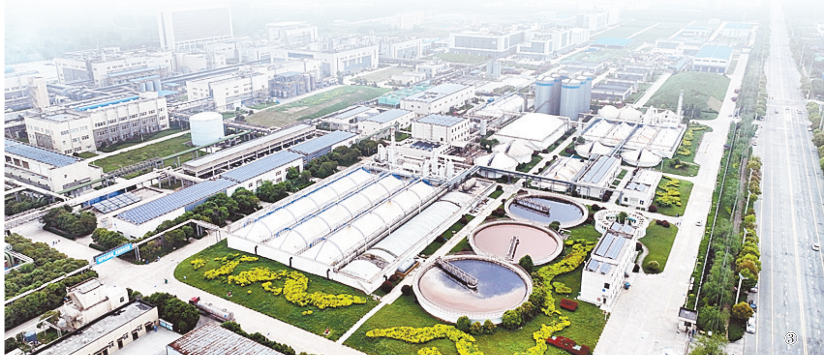
图① 天方药业把老旧的制冷机换成高效离心机,搭建能源管理平台,空调系统自动群控。图② 废水处理站工作人员采取水样。图③ 天方药业全景图。⑥3
