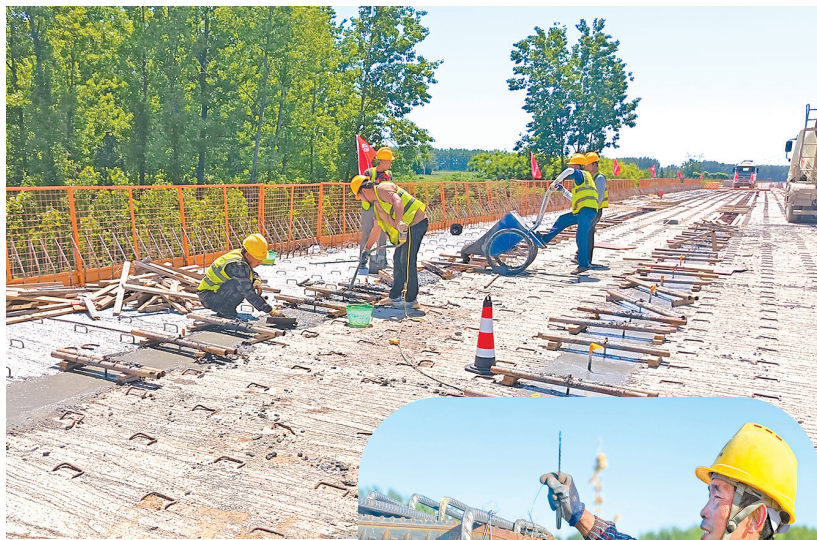
▲桥梁湿接缝浇筑施工。⑥5
