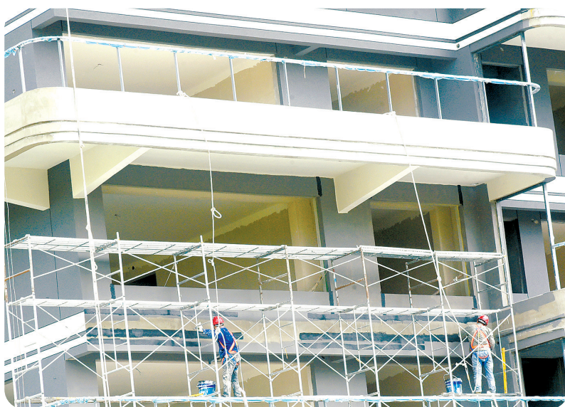
工人加紧施工。⑥3
