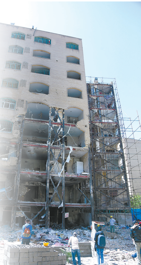
这是4月14日在伊朗首都德黑兰东南部一处居民区拍摄的遭美以袭击严重受损的楼房。美以袭击给居民区造成人员伤亡和严重财产损失，当地居民强烈谴责。 据伊朗伊斯兰共和国通讯社14日报道，伊朗政府发言人穆哈杰拉尼表示，战争赔偿问题是伊朗与美国之间的谈判以及在伊斯兰堡举行的相关磋商中的议题之一，初步估算伊朗损失达2700亿美元。 新华社记者 沙达提 摄
