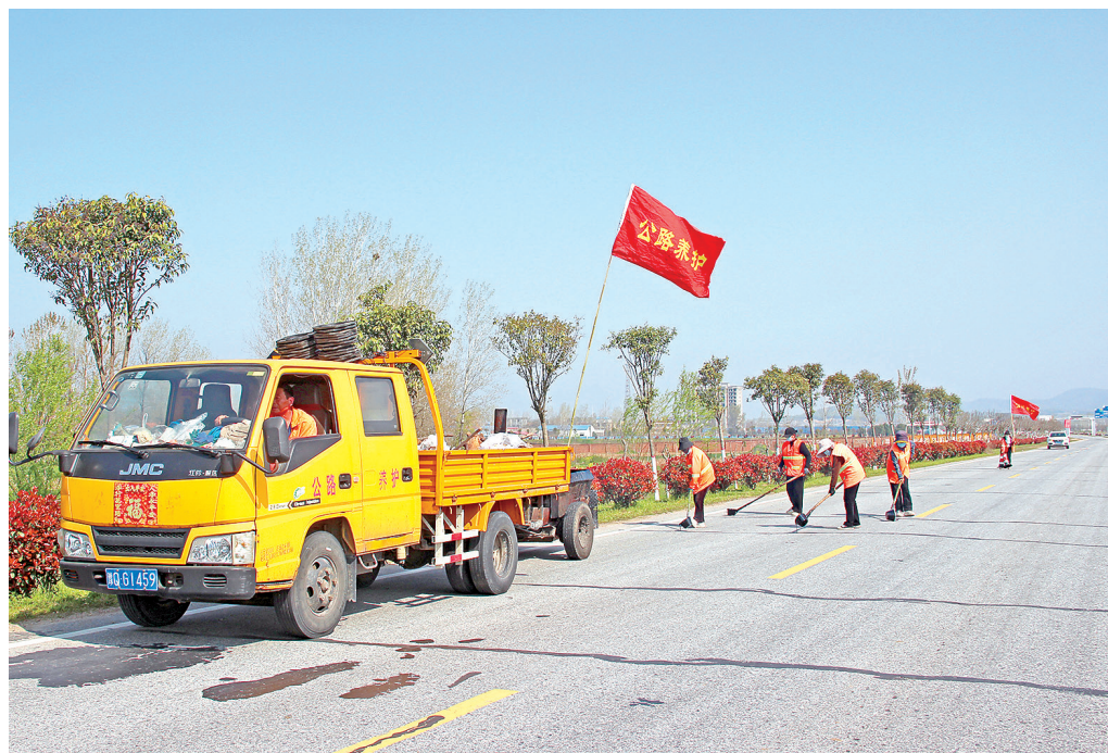
为抢抓春季公路养护黄金期,三月初以来,确山县公路事业发展中心科学部署、集中力量开展春季养护。养护人员对辖区普通公路进行全面排查,严格按照规范开展路面灌缝,同时修剪遮挡视线的绿化树木,清理路肩、边沟垃圾,全力打造“畅安舒美”的公路通行环境。⑥5
