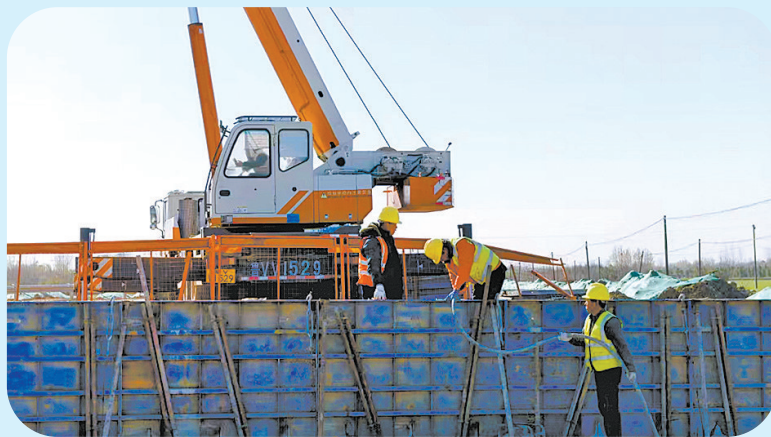
桥梁下部结构浇筑。⑥5
