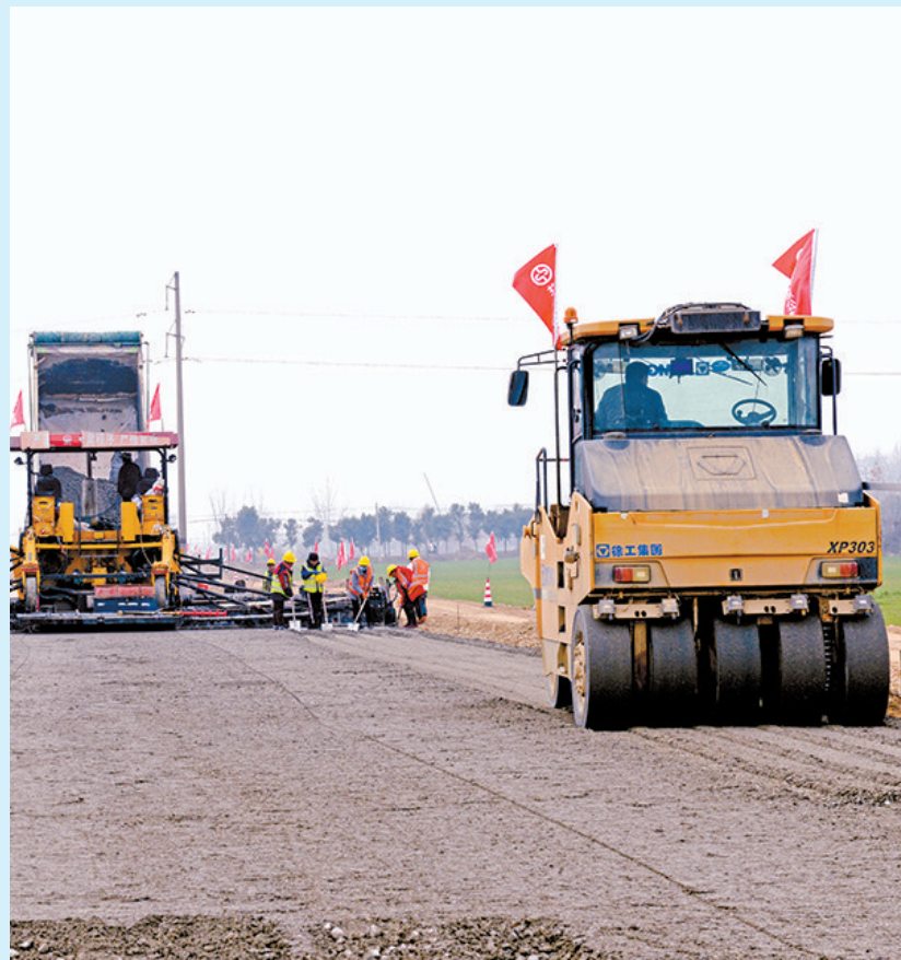
水泥稳定碎石摊铺施工。⑥5
