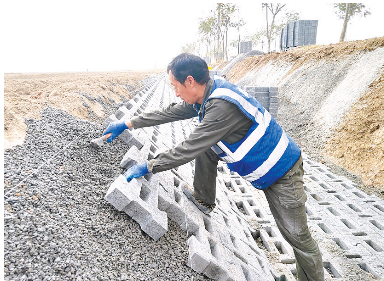
11月19日，在正阳县清源街道乐唐村高标准农田建设项目施工现场，施工队正在铺设田间沟坡。该县全力抢抓冬春季施工黄金期，积极推进高标准农田项目建设，全面打通农田水利“毛细血管”，让农田变“良田”，促进农业增产增收。⑥5
