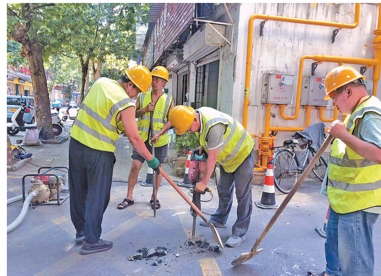
日前,位于市区人民街中段的一供水阀门发生渗漏,导致附近小区水压降低。为保障市民用水,管网维修人员顶着烈日加紧抢修。③3
