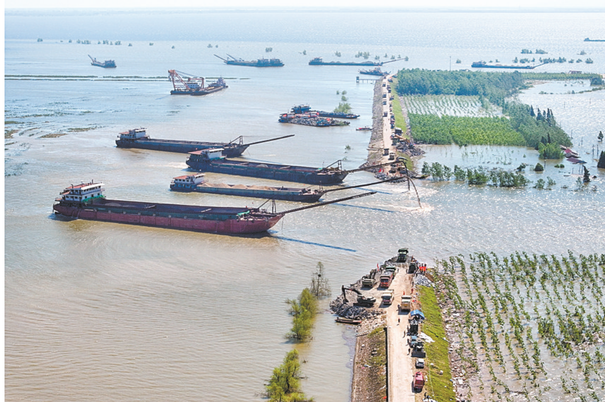
7月7日，在湖南省岳阳市华容县团洲垸洞庭湖大堤决口现场，抢险队伍在进行堵口作业（无人机照片）。 新华社记者 陈泽国 摄
