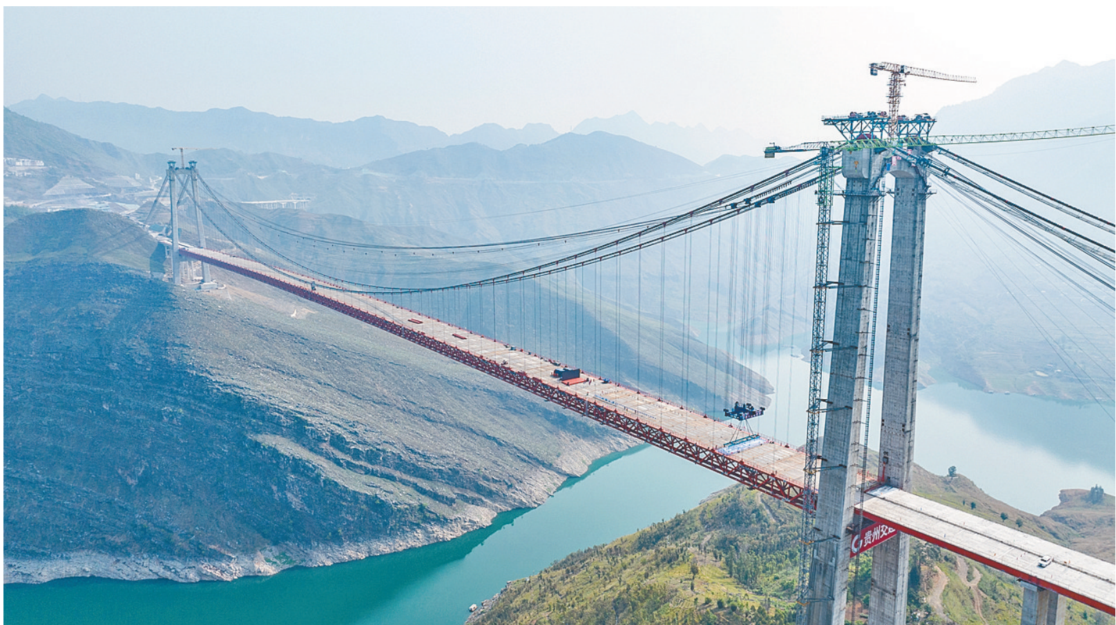
群峒江大桥吊装合龙施工现场(4月28日摄，无人机照片)。当日，随着最后一段钢梁吊装到预定位置，贵州交建集团投资建设的纳晴高速群峒江大桥顺利实现合龙，为纳(雍)晴(隆)高速全线建成通车打下坚实基础。群峒江大桥位于贵州省晴隆县和普安县交界处，大桥全长1849米，主跨1080米，桥面至江面最高距离380米。
