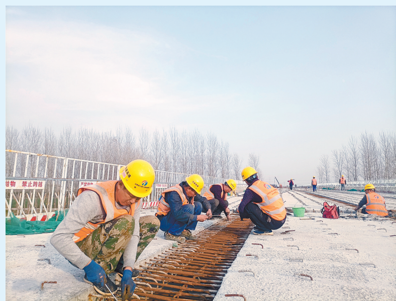
桥梁湿接缝钢筋绑扎。⑥5
