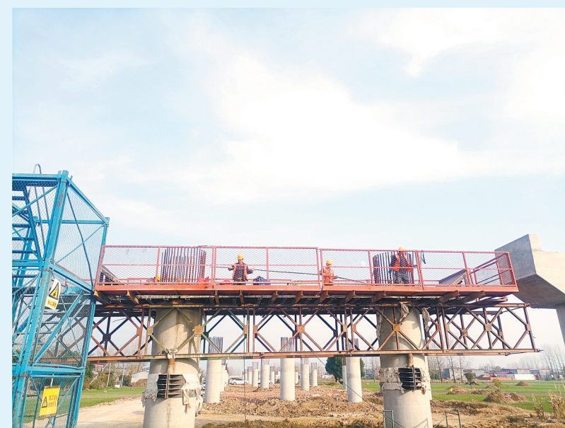
盖梁钢筋安装。⑥5
