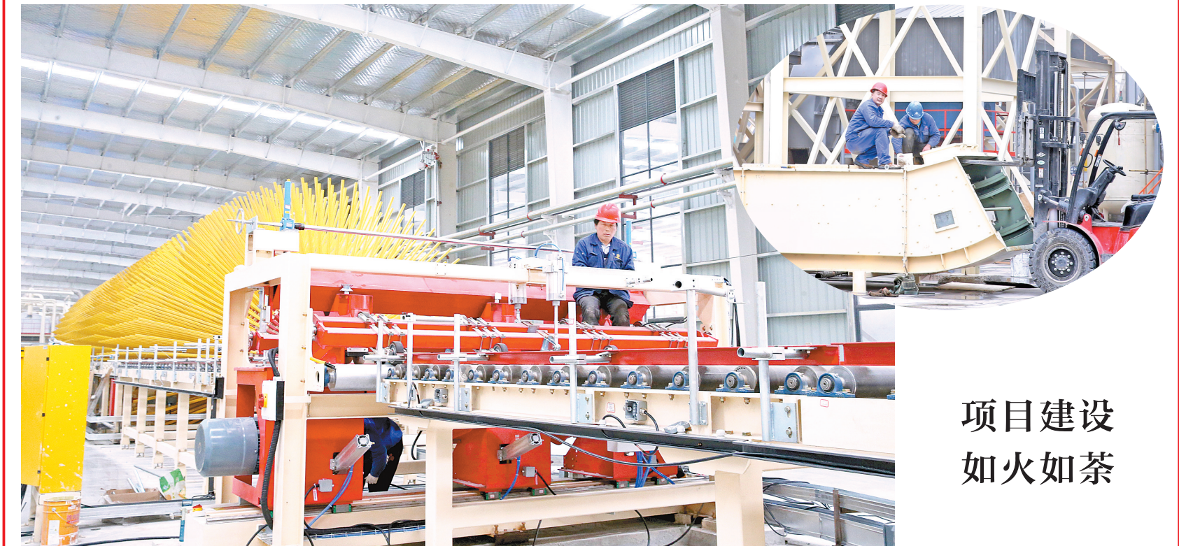
3月23日,位于新蔡县的佳诺威木业三期项目建设正如火如荼进行。该项目是河南熙泰科技有限公司投资4.5亿元兴建的,产品广泛用于家具、厨具领域,是国内外著名家装企业欧派、索菲亚和宜家的供应商。项目三期投资10亿元,目前正在全速建设中,预计2023年5月投产。项目建成后,主要生产高档无醛刨花板,运用于室内装饰、家具和木结构房屋建设等领域,可实现年销售收入20亿元,跻身全国同行业前三名。⑥5 记者 弓华静 摄
