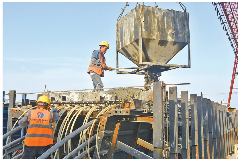
箱梁浇筑。⑥2
