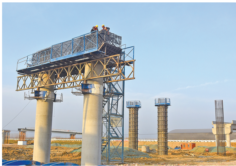
沈遂高速跨上罗高速刘楼枢纽互通工程施工现场。⑥2
