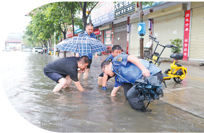
疏通被堵塞的排水设施。⑥5
