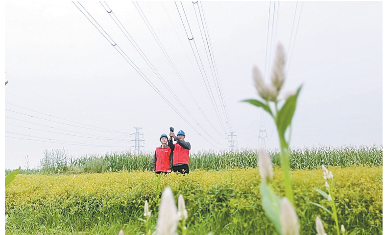
8月26日，国网新蔡县供电公司工作人员对110千伏古月1、古月2、古宋线路等高负荷线路进行特巡特护，确保电网稳定运行。⑥6 记者 万华翼 通讯员 蒋敏 摄影报道
