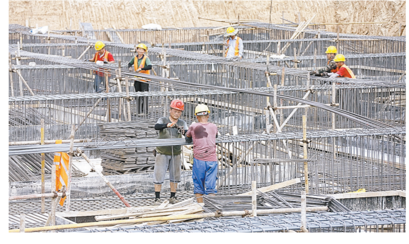
图为“中国药谷”超级工厂工地工人正在施工。⑥6
