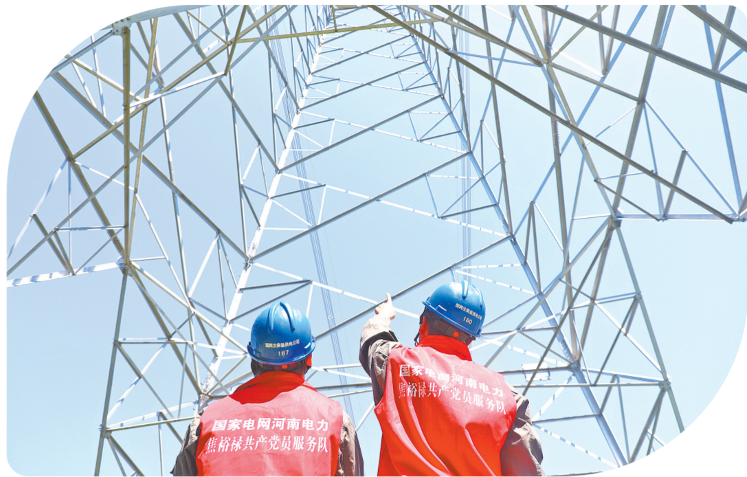
8月12日,国网汝南县供电公司焦裕禄共产党员服务队队员巡视±800千伏灵绍线。⑥6 通讯员 耿盛 摄
