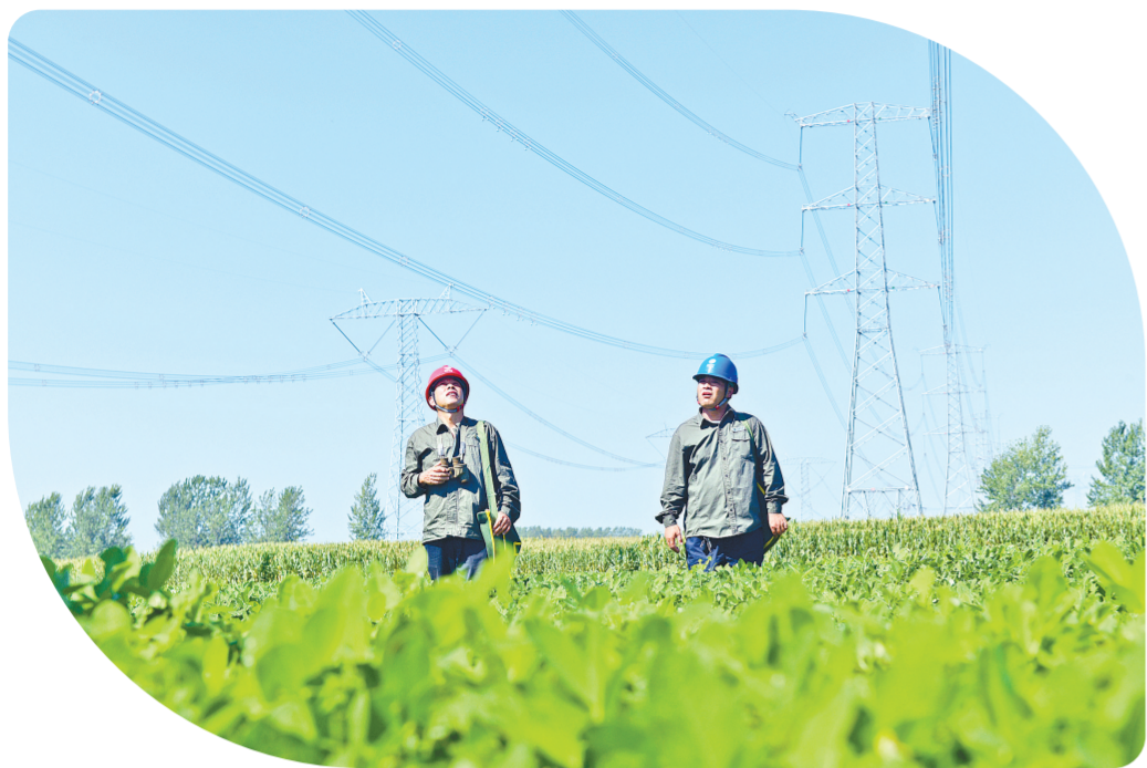
8月12日,国网西平县供电公司巡视人员正在对±800千伏灵绍线和1000千伏豫阳线重要地段进行巡视。⑥6 通讯员 宋鹏飞 摄
