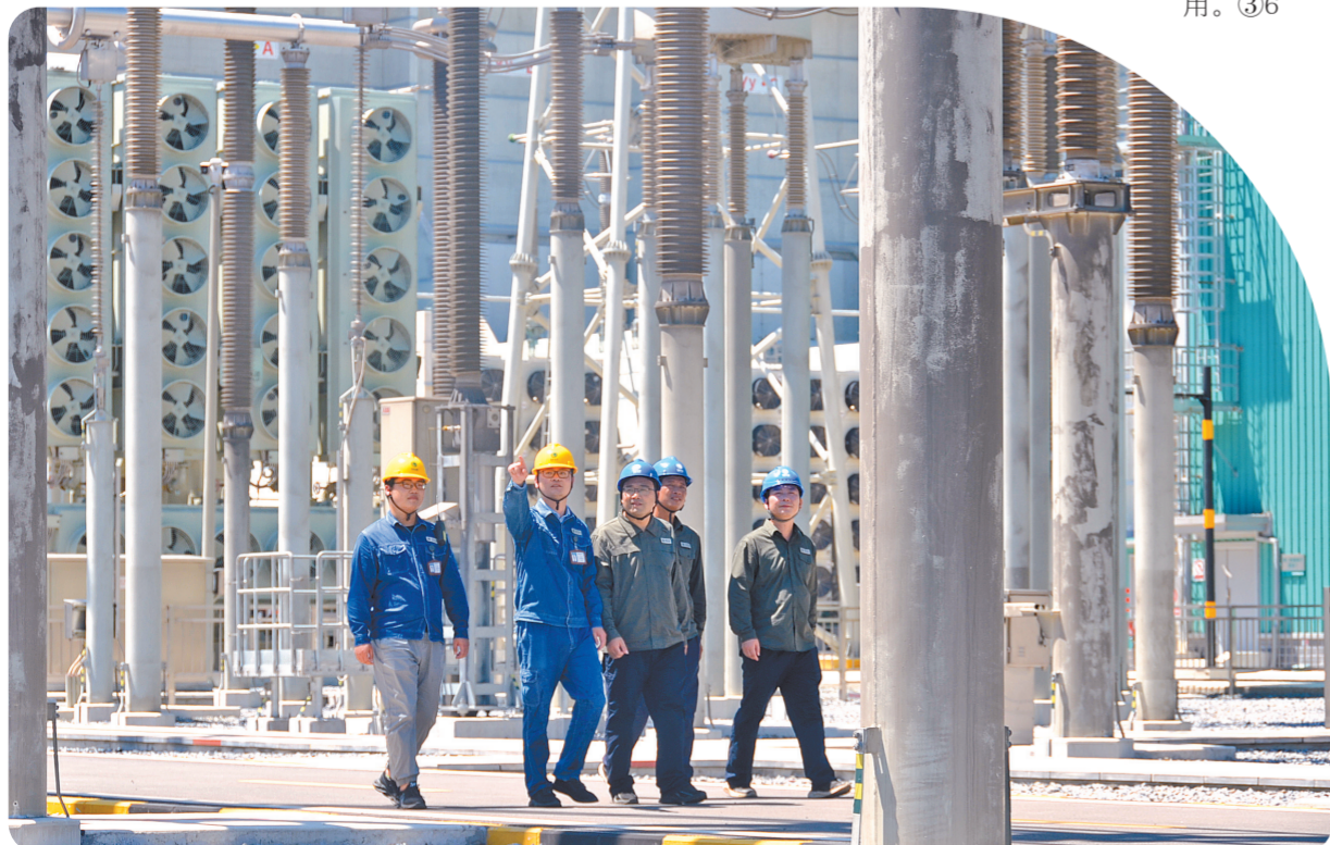
8月12日,国网上蔡县供电公司联合国网驻马店供电公司技术骨干与特高压豫南换流变电站专家进行实地学习交流,更好地发挥属地巡护线路作用。⑥6 通讯员 张海登 摄
