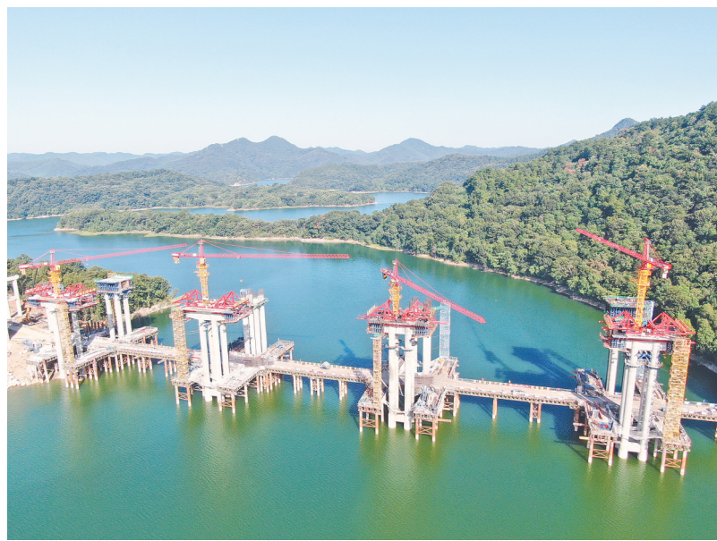
许信高速浥水河大桥施工现场。⑥5
