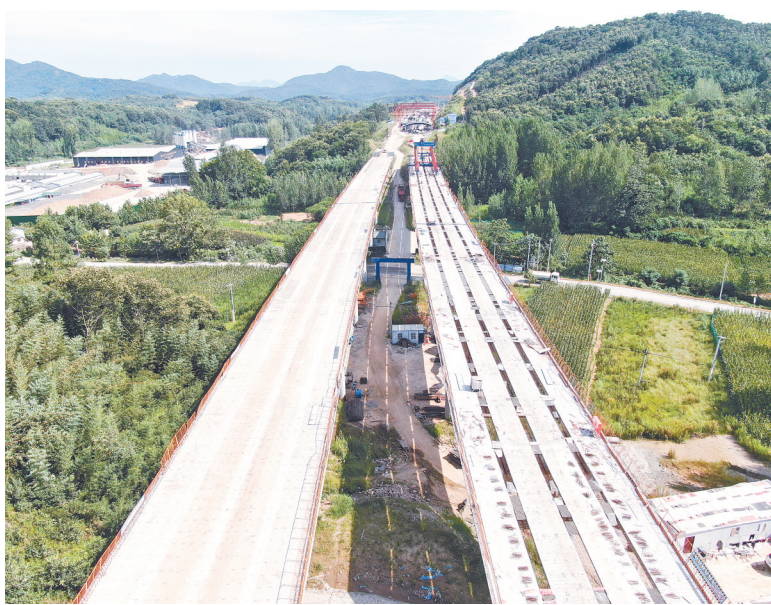
建设中的许信高速公路确山段。⑥5
