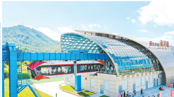
▲8月9日,“红轨”试验线列车驶出车站(无人拍照)。当日,国内首条稀土永磁磁浮轨道交通工程试验线——“红轨”,在江西兴国县正式竣工,并实现将稀土永磁磁浮技术与空轨技术结合,建成中低速、中低运量的新制式轨道交通系统。新华社记者 胡晨欢 摄
