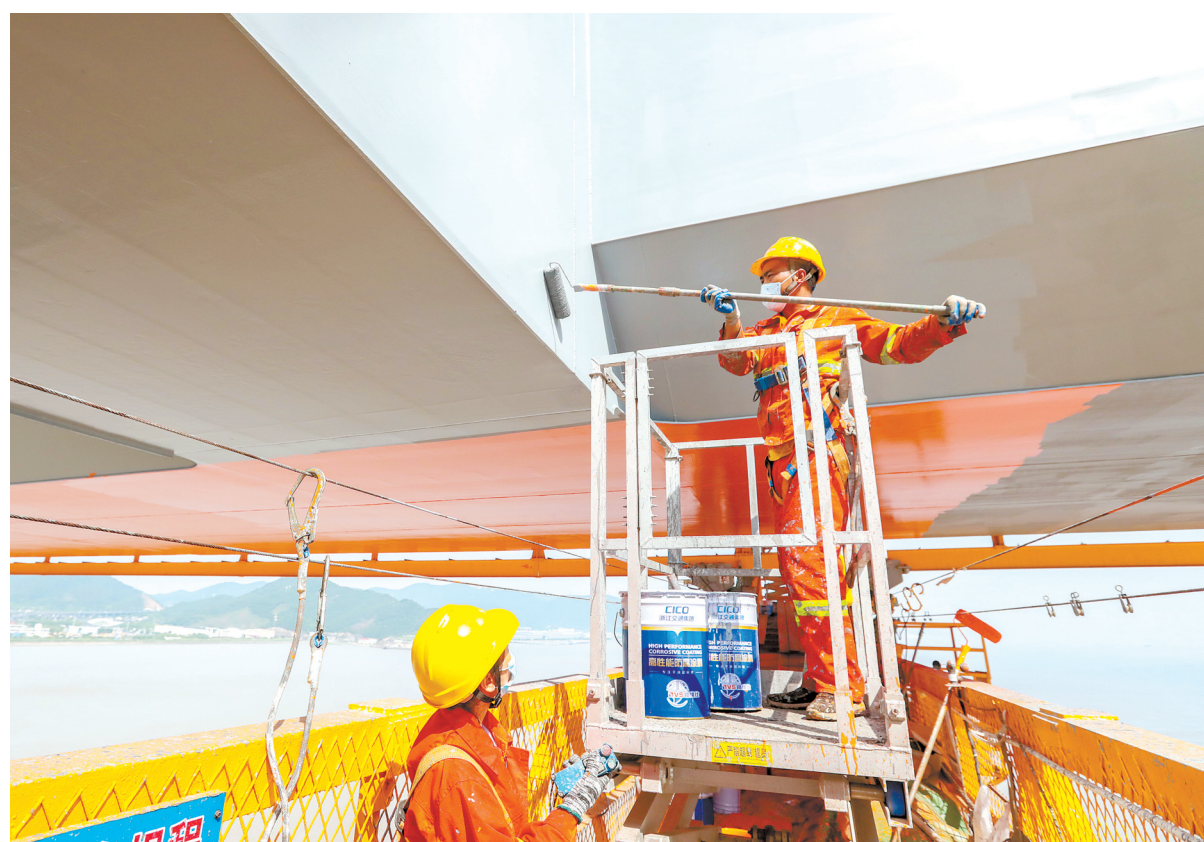
7月12日,浙江省交通集团桥梁养护工人为舟山西垅门大桥钢箱梁涂刷油漆。近日,全国多地持续高温,许多劳动者不畏炎热,坚守岗位,保障生产和人民生活。
