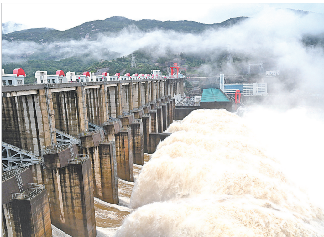
6月13日，福建水口水电站开闸泄洪。近期，福建闽江流域出现持续降雨，水位上涨，防汛形势异常严峻。为减轻闽江上游防汛压力，福建水电发电集团公司水库调度人员时刻关注流域水情变化，适时开闸泄洪。
