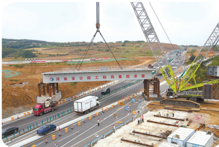
横山互通E匝道上跨钢箱梁顺利架设。⑥3
