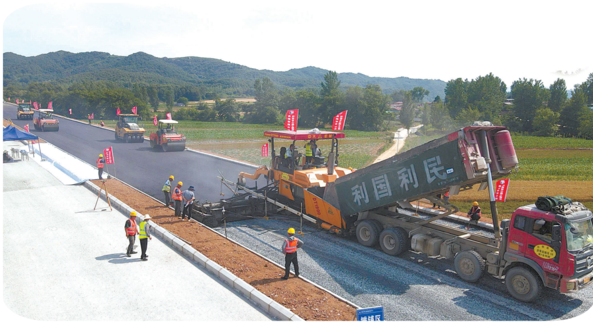
沥青下面层试验段顺利完成摊铺。⑥3
