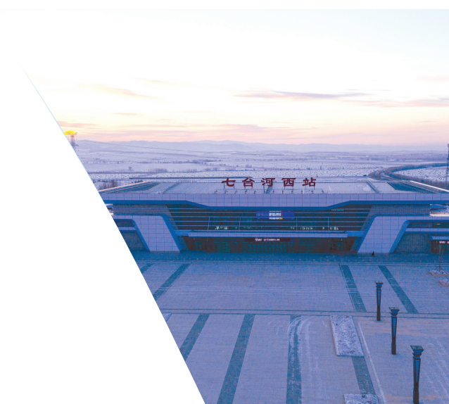
1月12日拍摄的黑龙江省七台河西站外景。2021年12月6日，七台河西站正式开通运营，车站左右对称，形似冰刀（无人机照片）。
