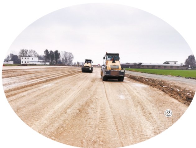
图① 箱涵钢筋骨架吊装。②9 图② 路基碾压施工。②9
