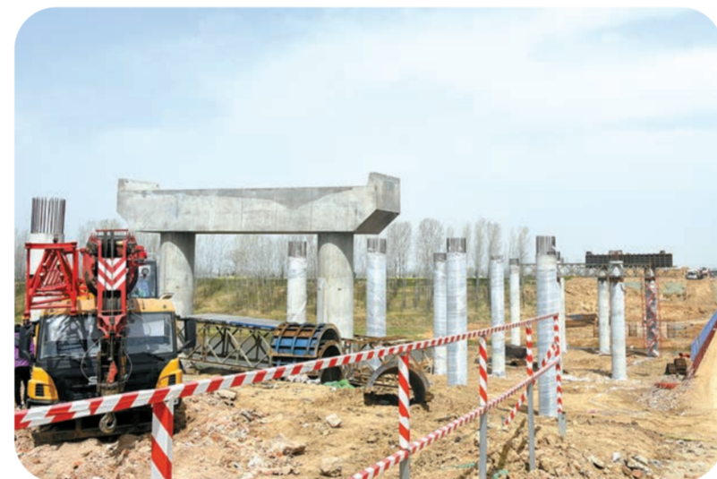
汝河大桥下部结构即将完工。②
