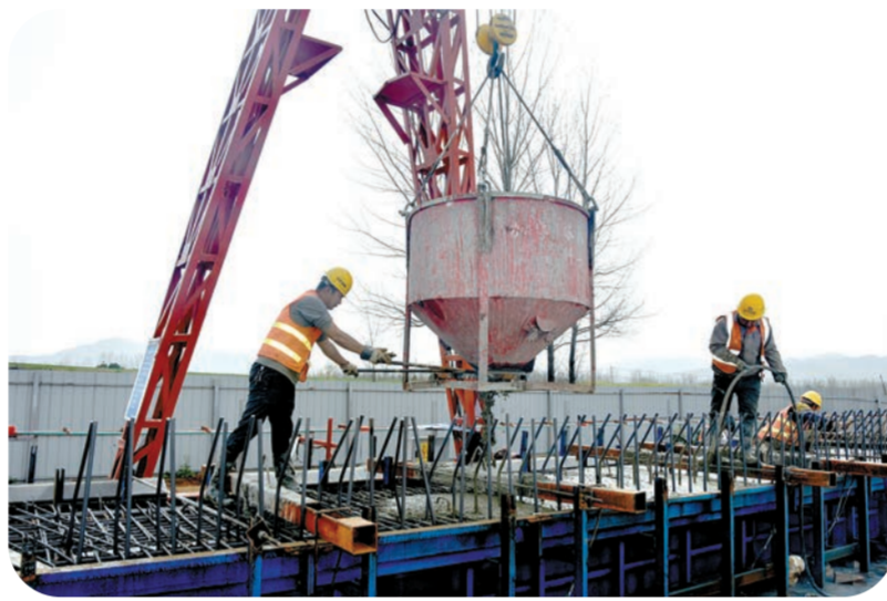
空心板混凝土浇筑。②
