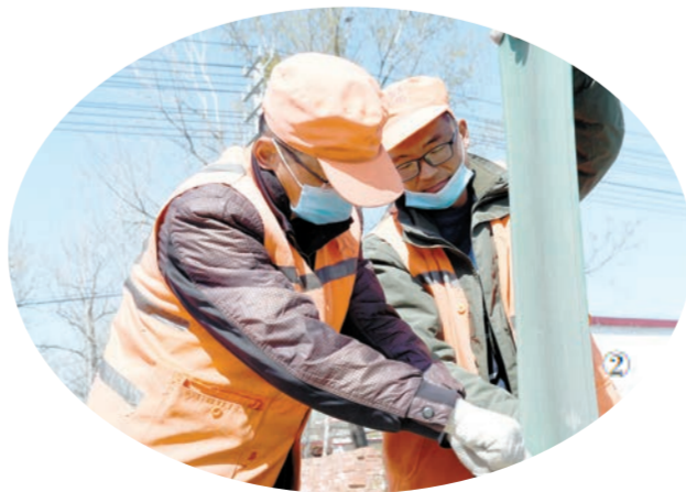
图① 灌缝作业。② 图② 维修防眩板。②
