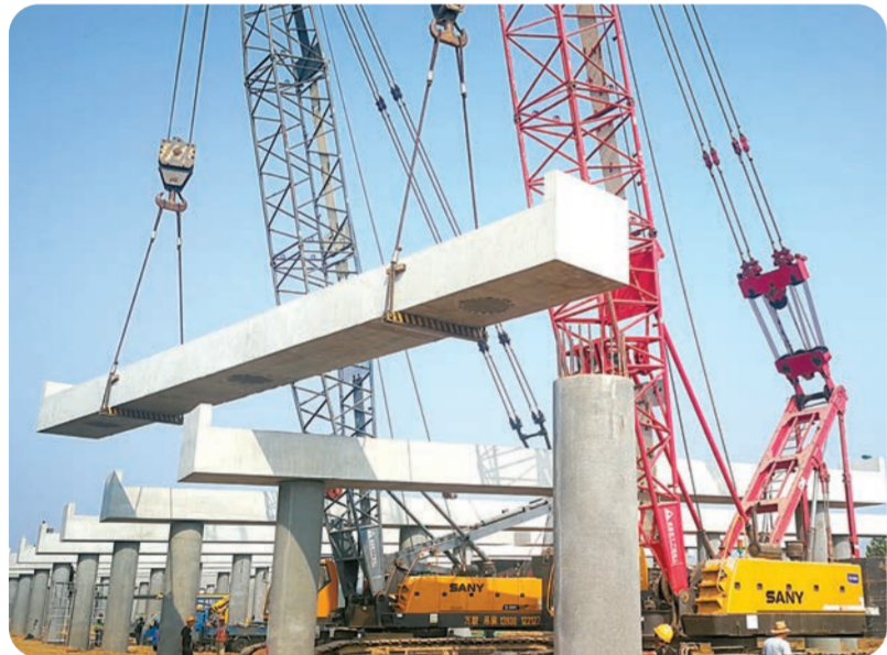
装配式桥梁施工。②3
